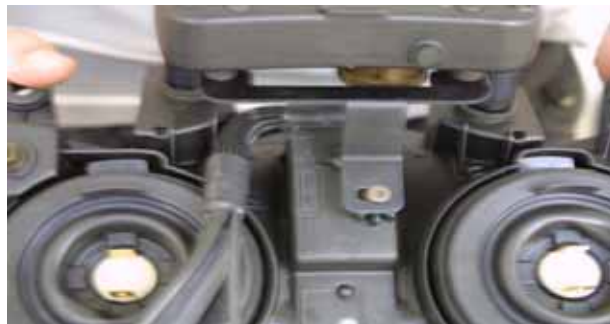
Figura 19: Installazione dei cablaggi.
